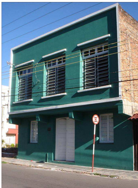
Figura 17 - Fachada da Sociedade Cultural Ferroviária Treze de Maio – Museu Treze de Maio, Santa Maria/RS Foto: Giane Vargas Escobar, 2007
